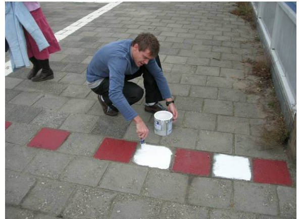
Structuur aanbrengen met verf
